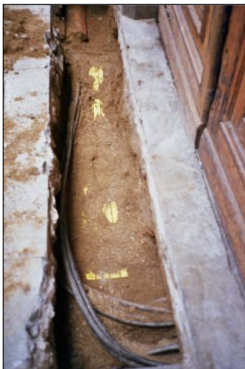
F.5. Detall dels serveis apareguts a la rasa U.E 2000, del C/ Sant Pere Més Baix.
