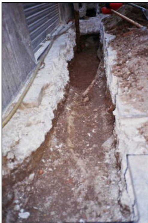
F.3. Detall dels serveis apareguts a la rasa U.E 1000, del C/ Sant Pere Mitjà.
