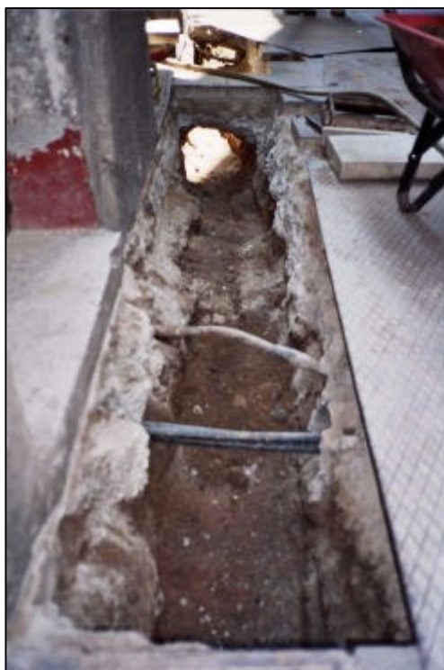
F.10. Detall dels serveis apareguts a la rasa U.E 2000, del C/ Mòneg.
