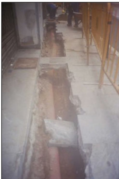
F.2. Vista dels serveis localitzats a la rasa U.E 1000, del C/ Sant Pere Mitjà.
