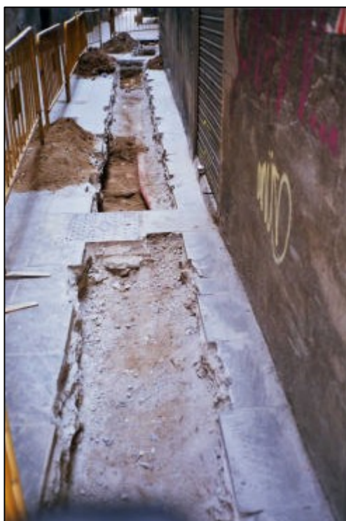
F.8. Vista general de la rasa U.E 3000, del C/ Mò nec.
