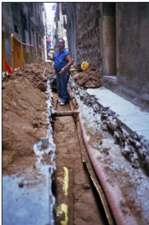
F.11. Detall del procés d'excavació de la rasa U.E 3000, del C/ Mòneg.
